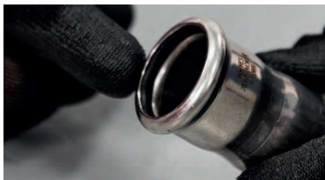
Figura 39 - Controllo O-ring
