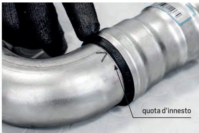
Figura 79 - Controllo completo inserimento del tubo nel bicchiere
