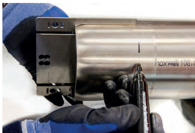
Figura 34 - Marcatura della profondità d'innesto con marcatore Ø 76 mm - Ø 88 mm - Ø 108 mm
