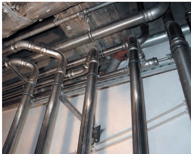
Figura 22 - inoxPRES - Esempio d'impianto
