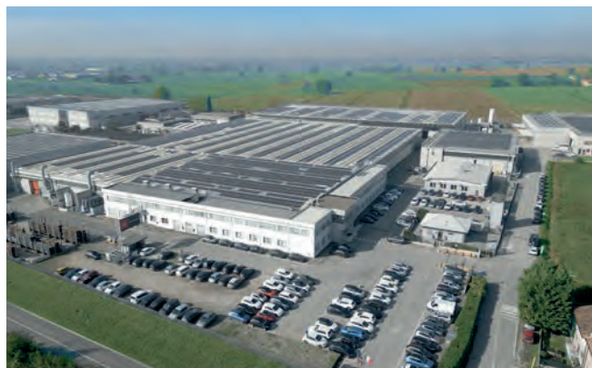
Figura 1 – Sede e stabilimento a Campitello
