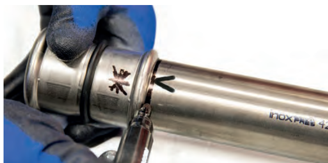
Figura 36 – Marcatura della profondità d'innesto con raccordo
