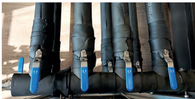
Figura 48 - Impianto coibentato
