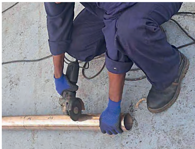
Figura 30 – Esempio di attrezzatura non idonea
